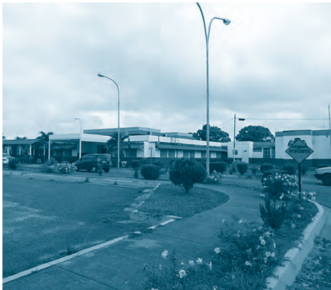
Sede UNEG, Guasipati.
